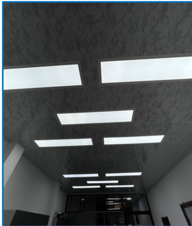
Figura 14. Cambio de luminarias LED .
